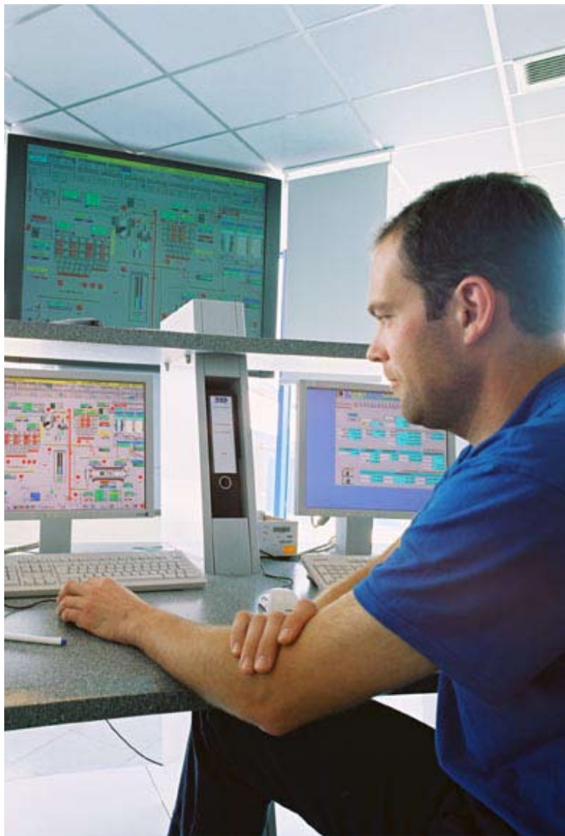
Vanuit een ultramoderne centrale bedieningsruimte sturen de operators de diverse installaties aan.
