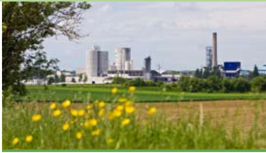
De modernisering van de fabriek is bezig
