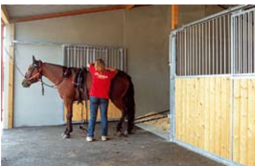
Helt öppningsbar front monterad mot betongmellanvägg
