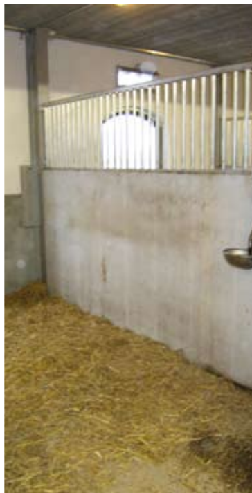
Halvhög betongmellanvägg med galler
