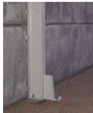
Betongvägg mot stålstomme med konsol för sarg
