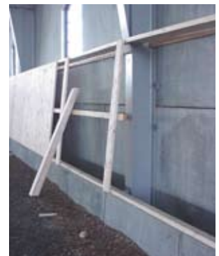
Sarg med betongsockel som enkelt monteras mot stålstommen
