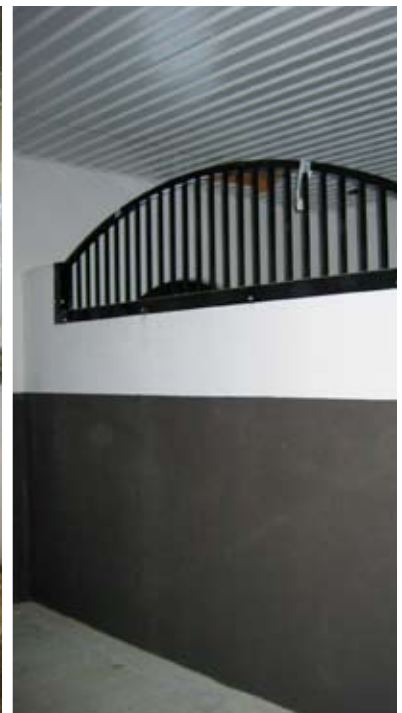
Hel betongmellanvägg med infällt galler
