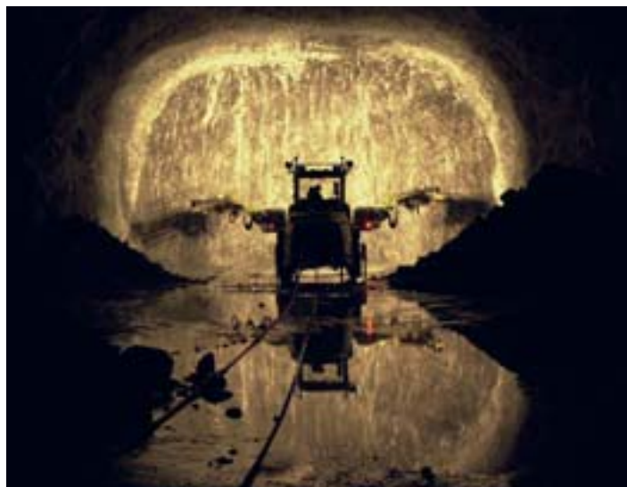
Når Mikrosement injiseres blir fjellet tett!
