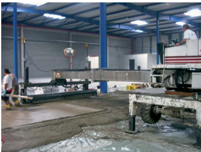
Bild 2: Betonage eines Industriebodens
