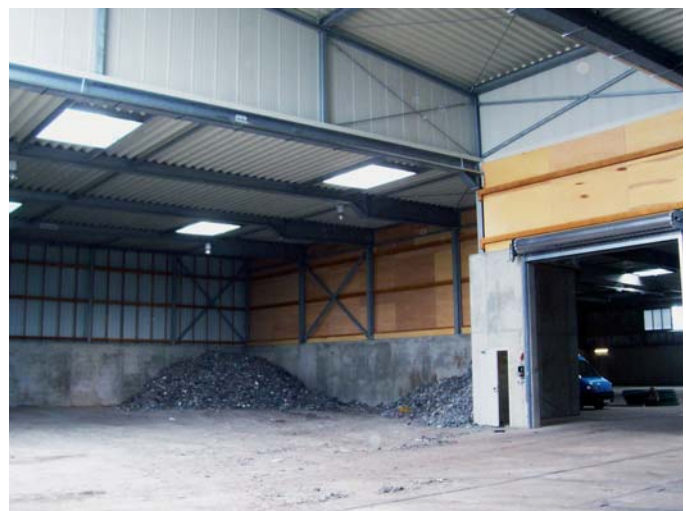
Bild 3: Biomüllkompostanlage, Bodenplatte und Wände ausgeführt in Steelcrete
