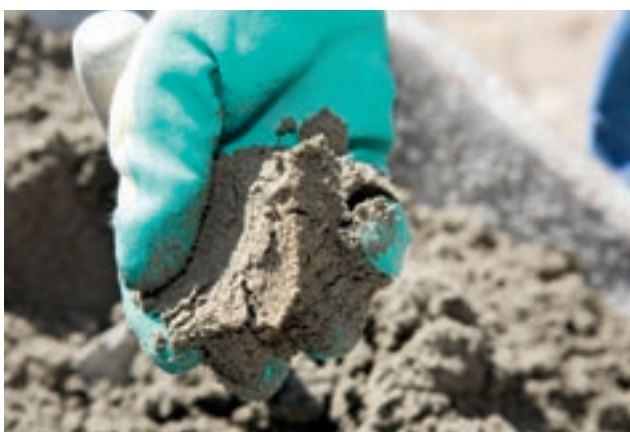
Consistentie van de voegmortel
