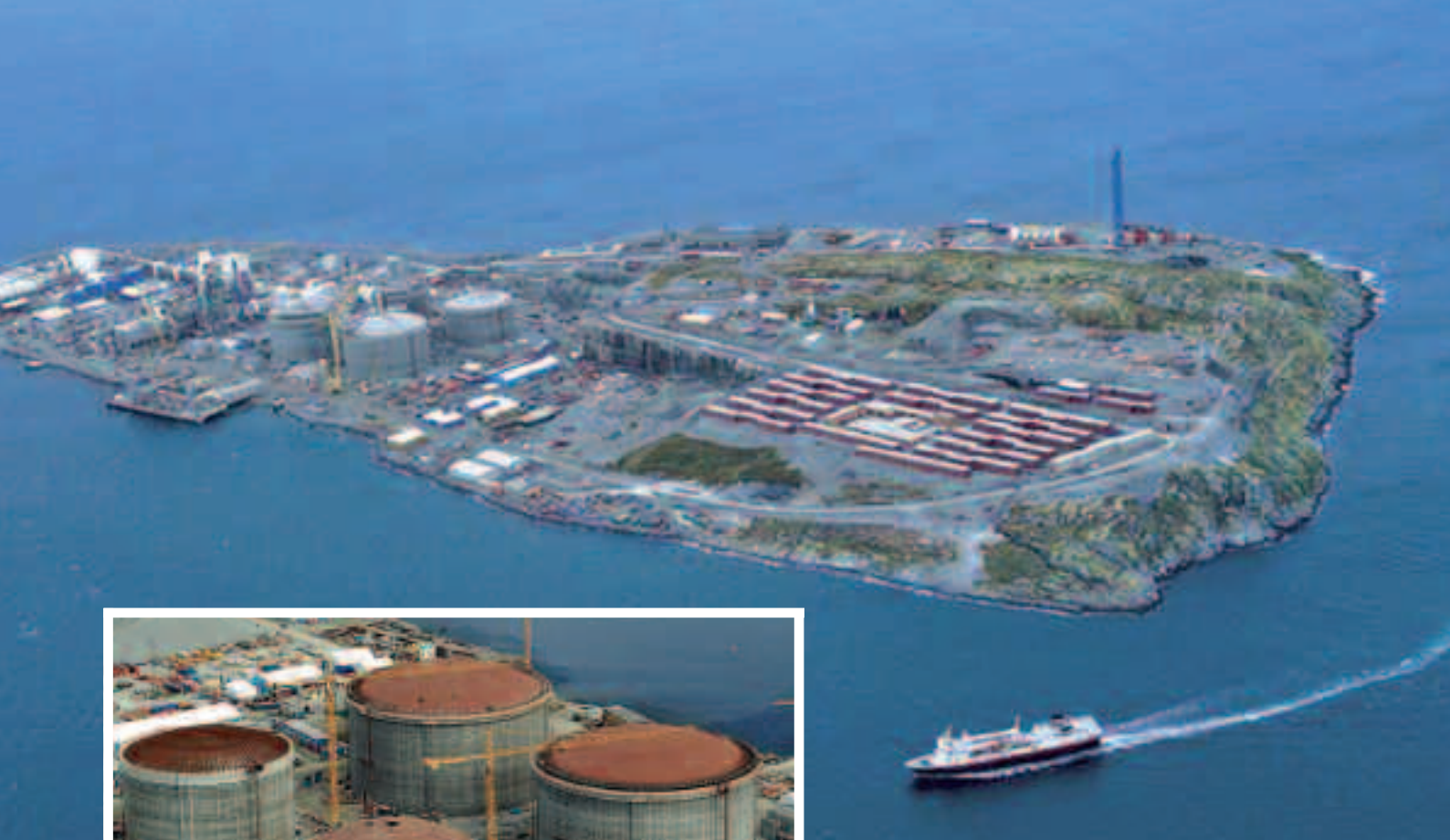
Tankfarmen på Melkøya bestående av 4 glidestøpte betongtanker for lagring av nedkjølt gass.
