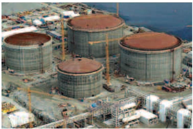
Tankfarmen på Melkøya bestående av 4 glidestøpte betongtanker for lagring av nedkjølt gass.
