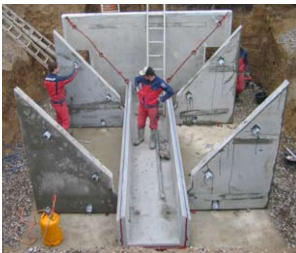
Platsgjuten bottenplatta ska vara utförd före montage. Resten levereras i färdiga delar.
