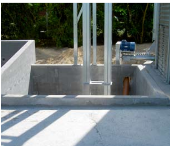
Med plats för utvärdig elevator.
