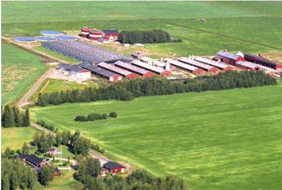
Figur 4.8.1 Flygfoto över biogasanläggningen i Alvik
