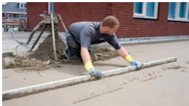
Uitvlakken met behulp van een rei
