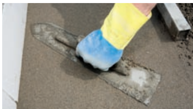
Afwerking: dichtstrijken met een stalen spaan
