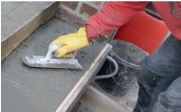
Les surfaces horizontales doivent être lissées.
