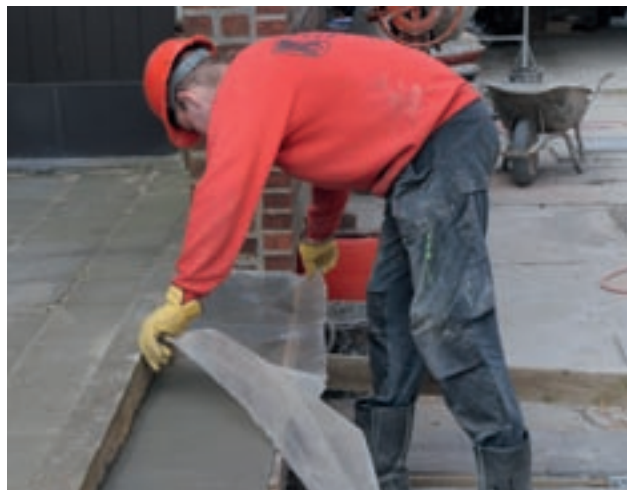
Évitez l'évaporation d'eau de surface en couvrant le béton frais d'une feuille de plastique.
