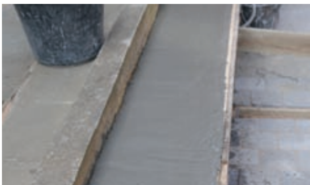
Le béton bien vibré a une surface brillante.
