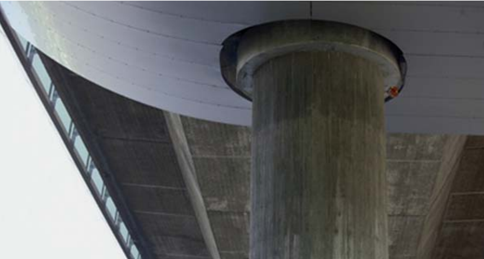
Selvkomprimerende betong (SKB) er brukt i de nye søylene.
