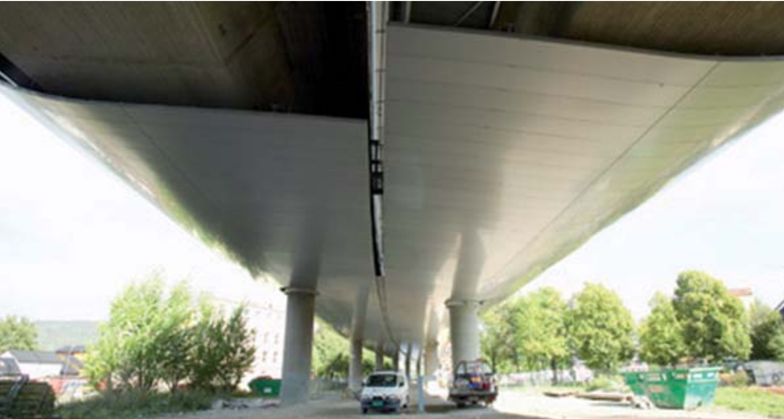
To broer bygges sammen til en og dekkes av 40000 m 2 aluminium.
