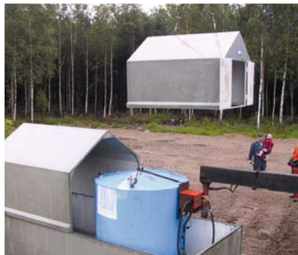
Takhalvorna monteras och infästes i botten- delen. Tack vare låg vikt kan varje takhalva även hanteras med vanlig traktorlastare. Fogning sker med medlevererad fogmassa.
