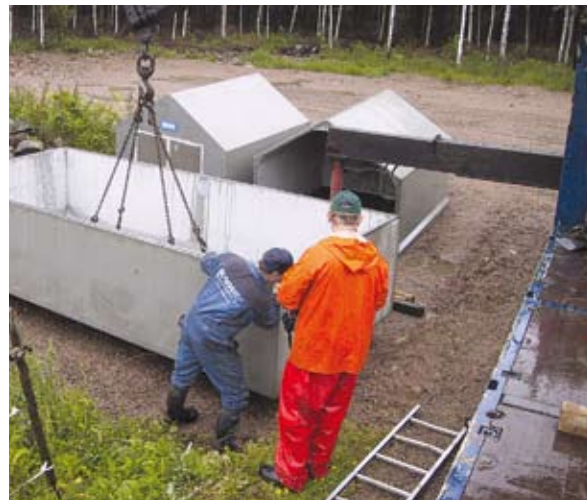
Bottendelen ställs på plats på en plan och väl avgrusad yta.
