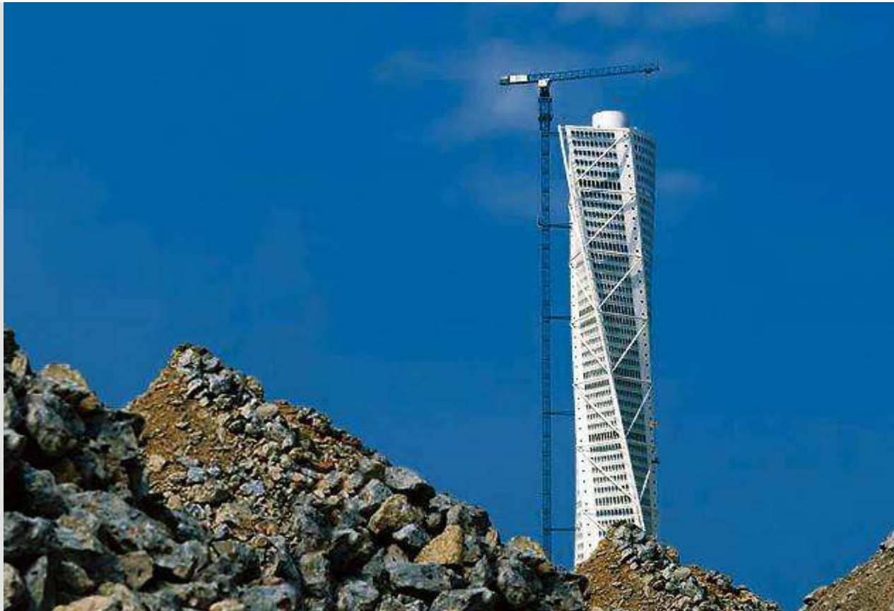
Turning Torso in Malmö, Schweden
