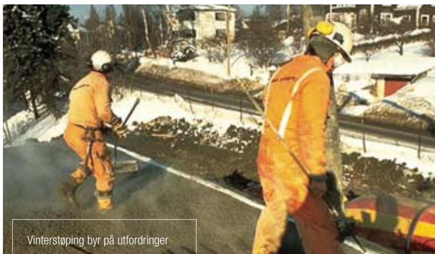
Tildekking med presenning er et fornuftig tiltak
