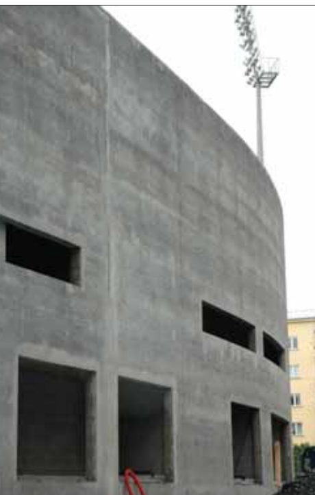
Stadionmurene ved Bislett plass er blitt stramme og elegante. Utsparinger til vinduer og innganger avslører kompleksiteten i glidestøpen.
