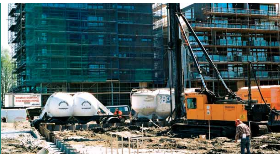
Kalksementpeler i grunnen under Holmen-tomta i Drammen
