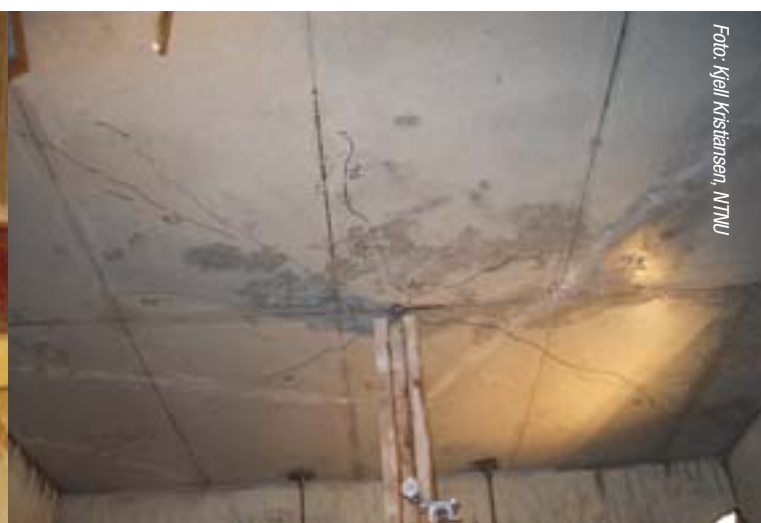
Underside av dekke. Opptegning av riss og måling av nedbøyning.
