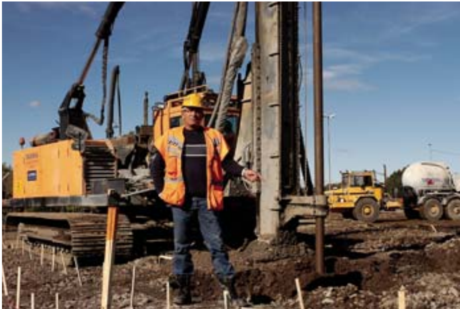
KC-peling er den beste tekniske løsningen for å skape fast byggegrunn av denne leiremassen, fastslår byggeleder Dag Ødegård i Statens vegvesen. Pinnene i forkant markerer hvor de neste pelene skal anlegges.
