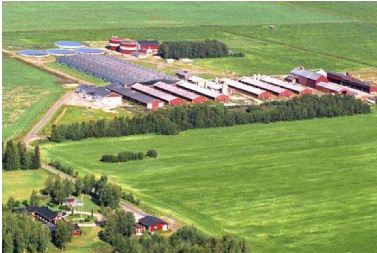
Figur 4.8.1 Flygfoto över biogasanläggningen i Alvik
