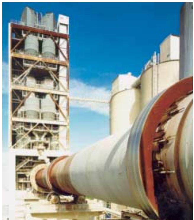
5 Ofenanlage im Werk Milke 5 Kiln plant at the Milke works
