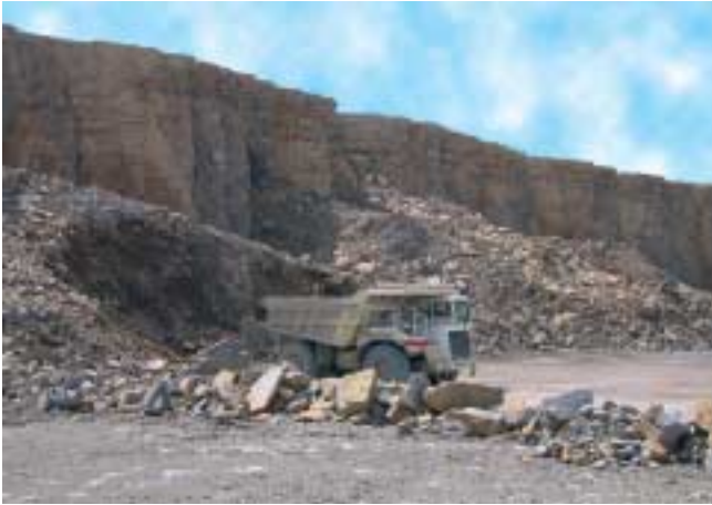
3 Steinbruch im Werk Milke 3 Quarry at the Milke works
