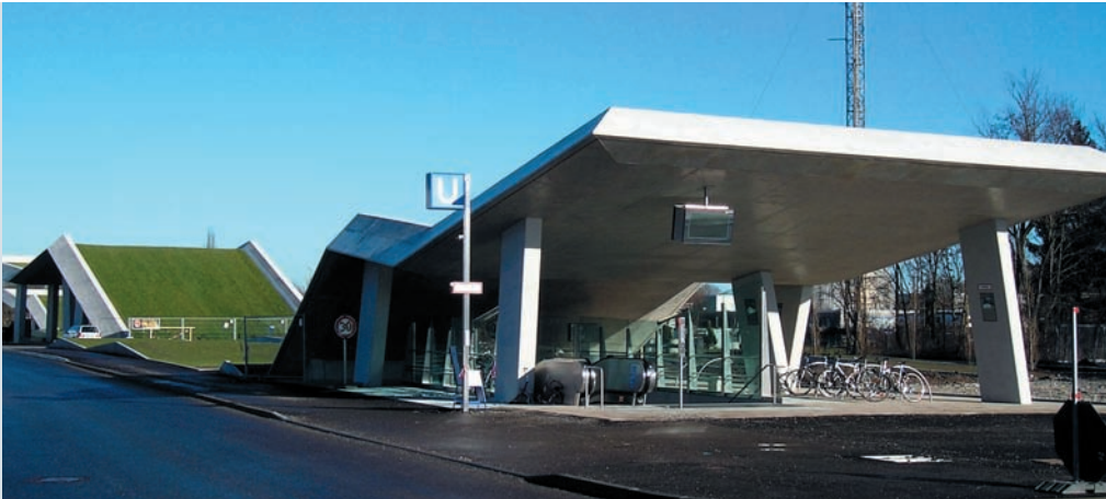
Architekturbeton der Extraklasse: Ausgangsüberdachung des U-Bahnhofs Garching.
