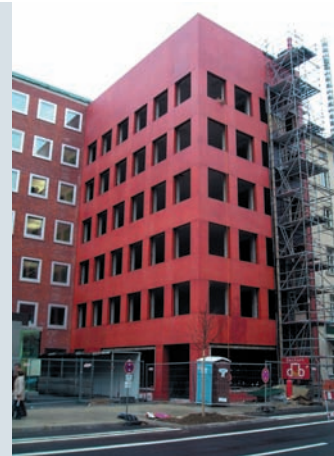
Roter Sichtbeton für die Fassade des Neubaus der Stadtwerke München.
