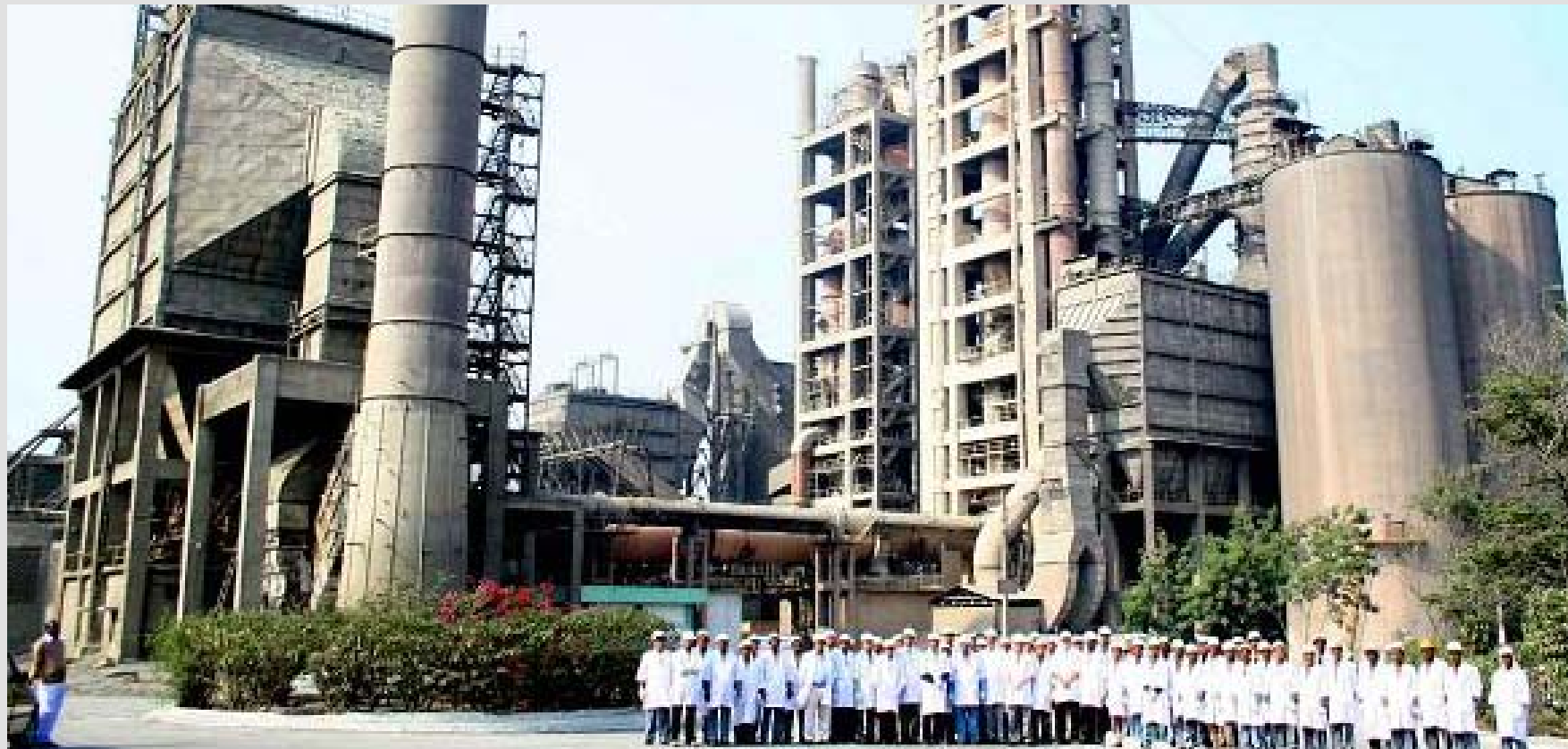
Zementwerk Narsinggarh von Mysore Cements in Indien
