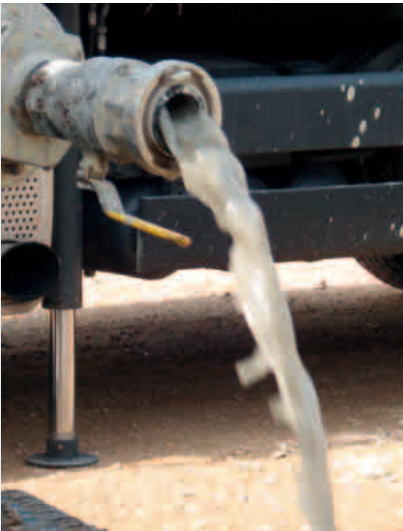
Überlauf des im Bohrloch verdrängten Wassers
