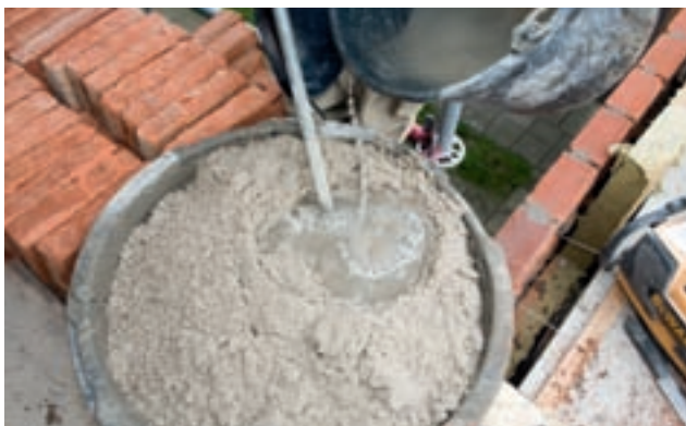
Mengvolgorde: het resterende water toevoegen tot de gewenste verwerkbaarheid is verkregen
