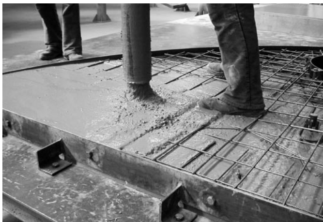
Bild 5: Herstellen eines Deckenelements aus SVB (aus [10])
