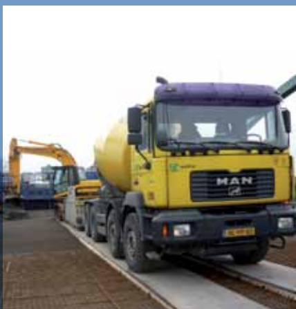
Mebin ontwierp een speciaal mengsel van hogesterktebeton voor de versterking van de stalen brug bij Beek.
