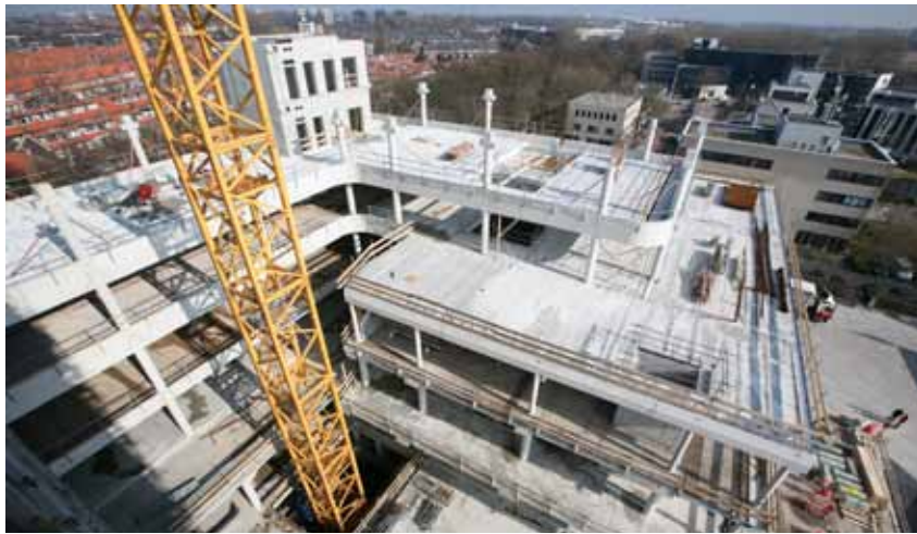
Toepassing van VBI klimaatvloerdelen, Roc (Leiden).
